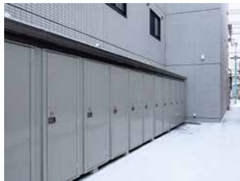
▲ 全戸トランクルーム完備
